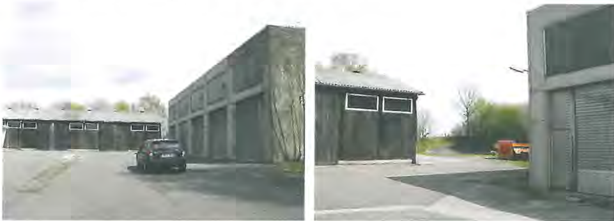
Bild 2 und 3: Lager- und Werkstattgebäude der ehemaligen Kreisstraßenmeisterei
