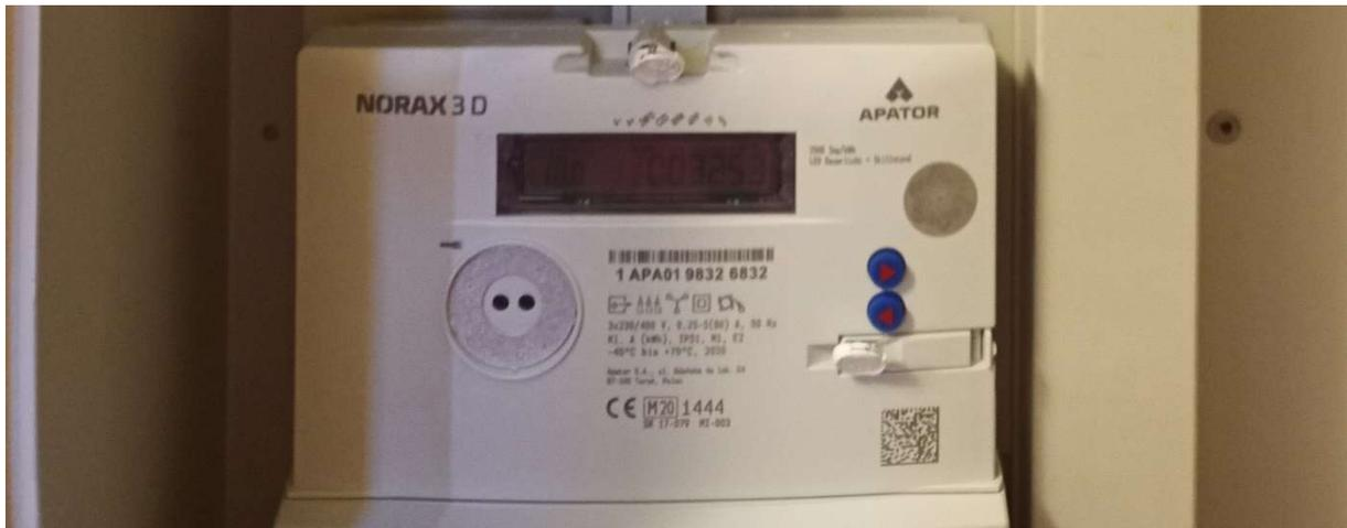
Es handelt sich bereits um eine moderne Messeinrichtung mit Rücklaufsperrre. Der alte Stromzähler (Ferraris-Zähler) wurde bereits im Juni 2022 gegen diesen Stromzähler ausgetauscht.
