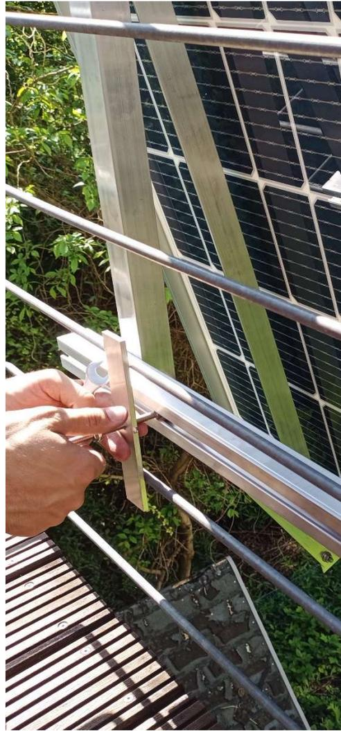
Zunächst wurde die Unterkonstruktion mit dem vorgesehenen Winkel von  $15^\circ$  auf das Modul montiert und dann das ganze Modul an den Handlauf des Balkongitters gehängt und in die Endposition geschoben.
