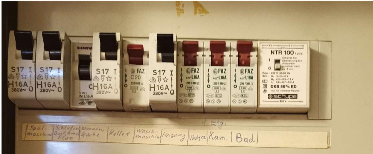
Die Steckdose auf der Terrasse ist über den 16A Sicherungsautomaten „Keller“ abgesichert.
