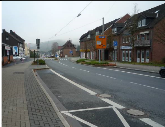
Olper Straße im Bereich Altenbrück (zwischen Holzbachstraße und Bücheler Straße)
