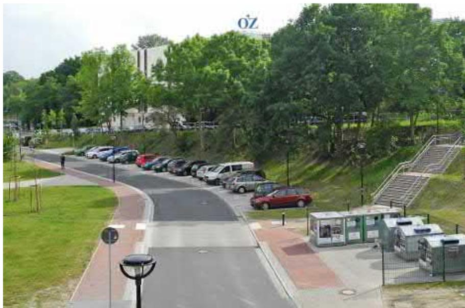
Abbildung 74: Aufpflasterung der Bahnhofstraße in Rostock
