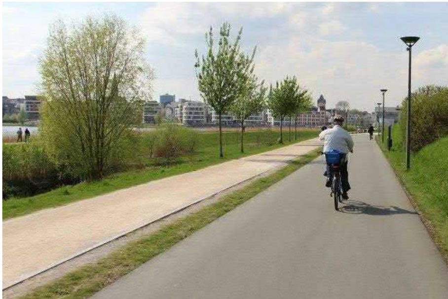
Abbildung 94: Radweg mit asphaltierter (rechts) und wassergebundener (links) Deckschicht
