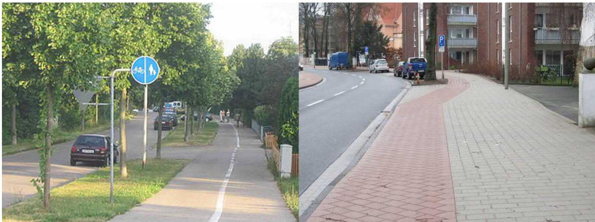
Abbildung 98: Markierungstrennung zwischen dem Rad- und Fußgängerverkehr
