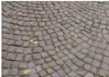
Kleinsteinpflaster aus Grauwacke
