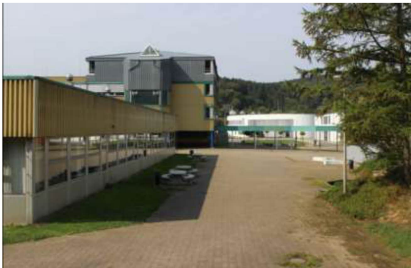
Abb. 58: Schulzentrum u. Anbindung Quelle: eigene Bilder
