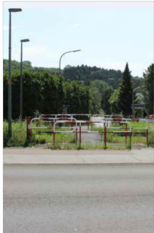
Abb. 38: Bahnübergang Siegburger Str. Quelle: eigene Bilder
