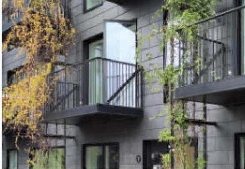
Schieferfassade mit Fassadenbegrünung
