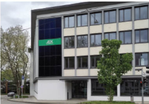
An Fassadestruktur angepasste Photovoltaikanlage
