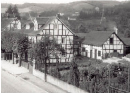
Historische Fachwerkbauung an der Hauptstraße (Foto: Stadtarchiv Overath)
