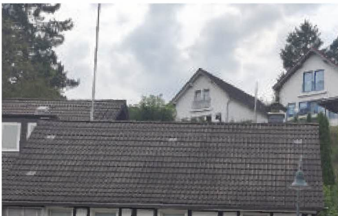
Ortstypische dunkle Dacheindeckungen
