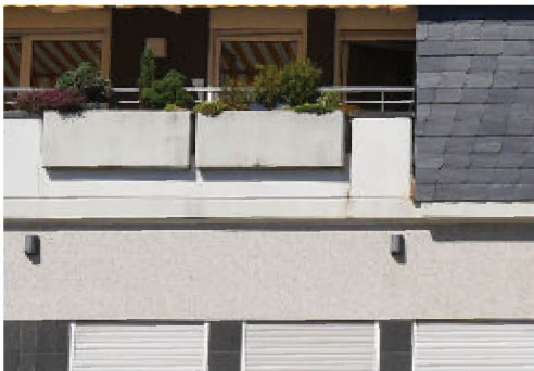
Kombination von Schiefer, Sichtbeton und Putz
