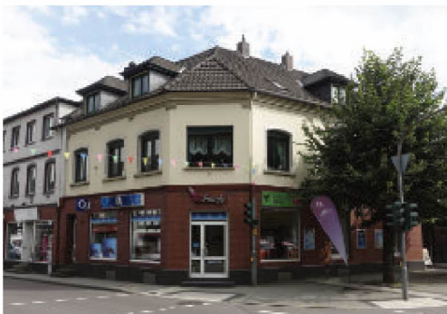
Betonung des Eckgebäudes an der Kreuzung Hauptstraße / Propsteistraße
