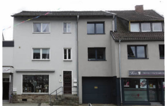
Gebäude mit verputzter Lochfassade (Hauptstraße)
