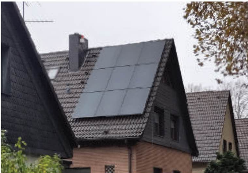
An die Dachfarbe angepasste Photovoltaik-anlage
