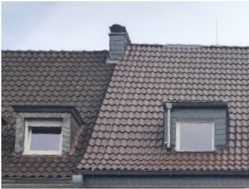
Ortstypische dunkle Dacheindeckungen
