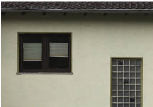
Verputzte Lochfassade und Glasbausteine
