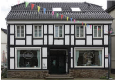
Durchgehende Sturz- und Brüstungshöhe
