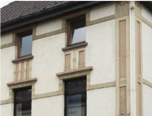
Putzfassade mit dunkler Akzentfarbe
