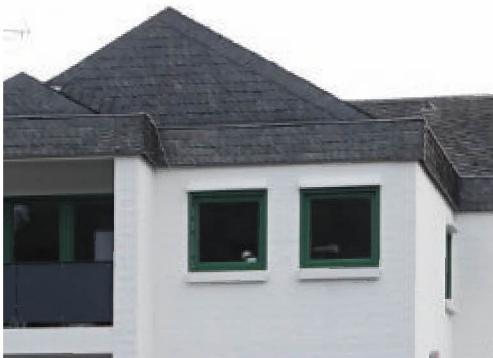
Kombination von Schiefer und Putzfassade
