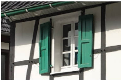
Historisches Fenster mit ortsbildprägenden Fensterläden aus Holz
