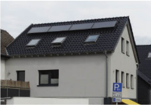
An die Dachfarbe angepasste Photovoltaik-anlage
