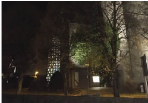
Akzentbeleuchtung der Kirchenfassade
