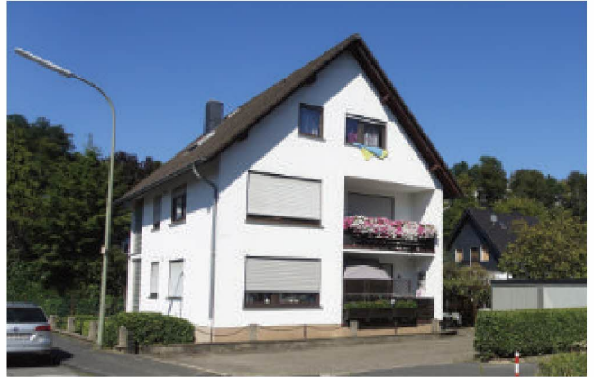
Frei stehendes Mehrfamilienhaus (Parkweg)
