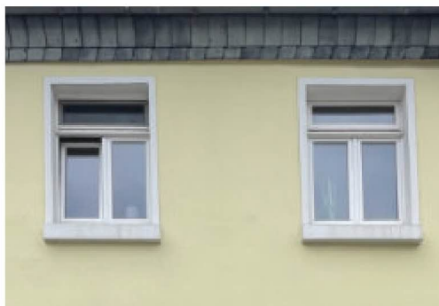
Erhalt von Gestaltungsdetails nach energetischer Sanierung
