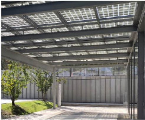
Überdachung mit integrierten Photovoltaikmodulen
