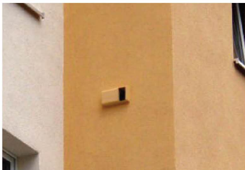
In die Fassade integrierter Kasten für Nischenbrüter (Quelle: Schwegler GmbH)
