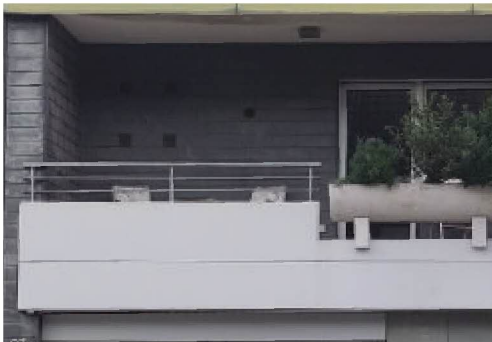
Kombination von Schiefer und Sichtbeton
