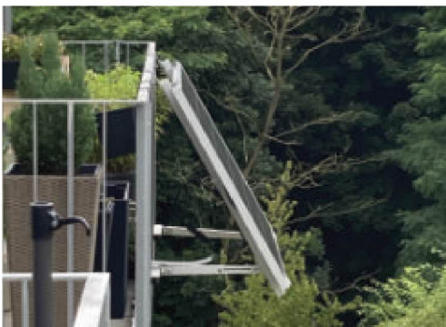
Balkonkraftwerk
