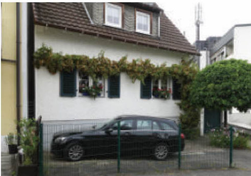
Horizontal geleitete Fassadenbegrünung
