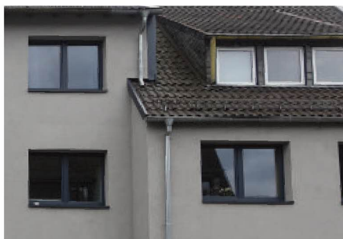
Energetisch sanierte Putzfassade
