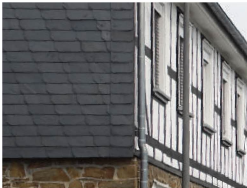
Schiefer-Brandwand und Natursteinsockel
