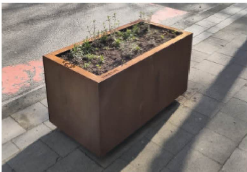
Pflanzkübel als Überfahrsperrre
