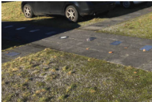
Parkplatzfläche mit Schotterrasen
