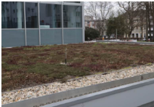
Dachbegrünung eines Anbaus
