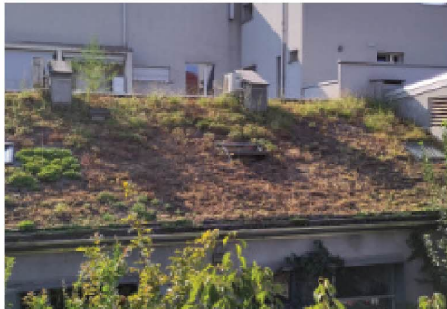
Dachbegrünung eines Pultdachs
