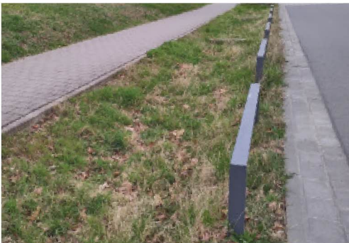
Einfache Mulde entlang einer Straße
