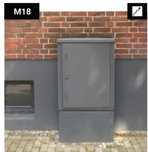
Verteilerkästen können künftig zurückhaltend gestaltet werden und sich in ihre Umgebung einfügen.
