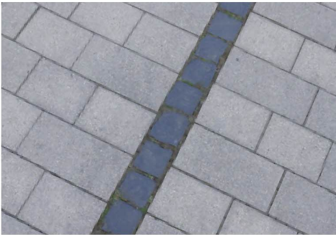
In das Pflaster integrierte Leitlinie
