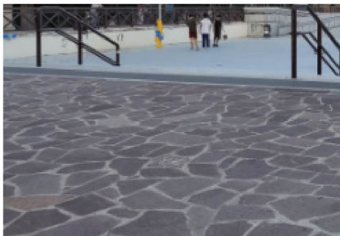
Polygonal verlegte dunkle Natursteinplatten
