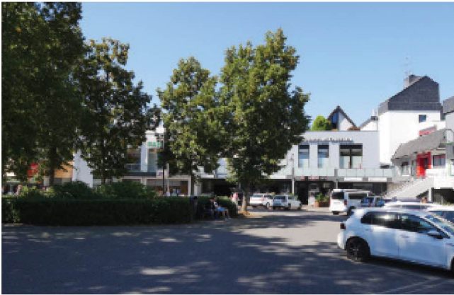
Blick auf den Steinhofplatz
