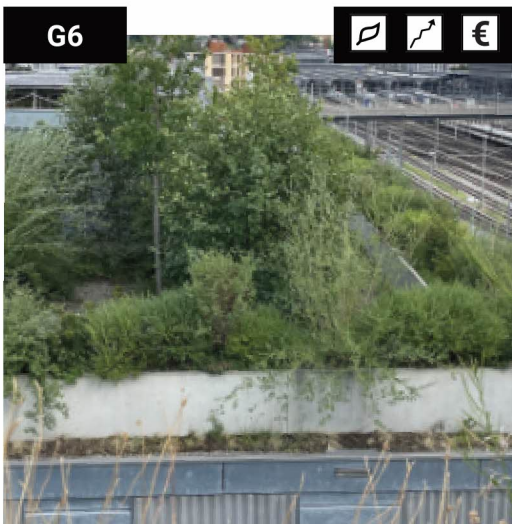
Neubauten aber auch Bestandsgebäude und Nebenanlagen können mit Gründächern versehen werden, um den Vegetationsanteil zu erhöhen.
